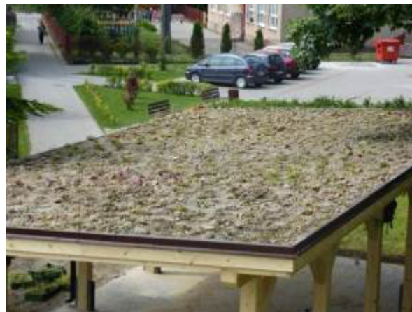
Vegetačná strecha po ukončení realizácie
