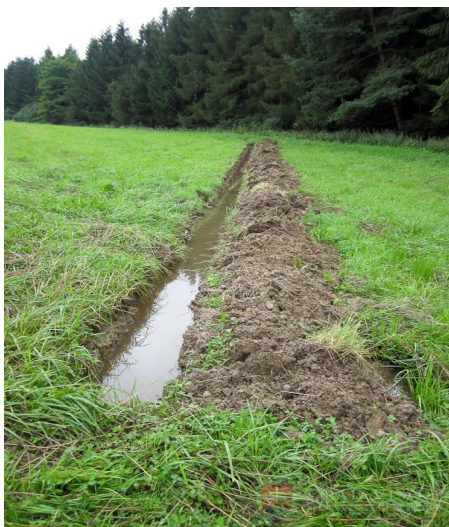
Infiltračná priekopa bezprostredne po realizácii
