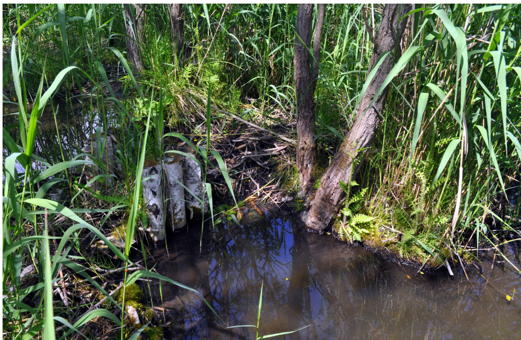
Prehrádzka tvorená dvoma radmi drevených kolov, medzi ktorými je nabitá rašelina, lokalita Krivý Kút (Spišská Belá)
