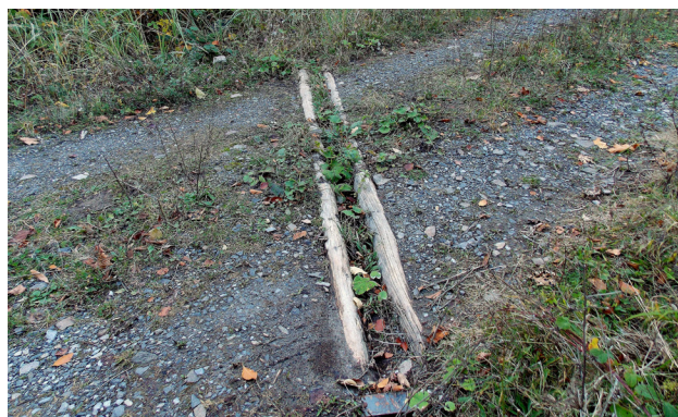
Znefunkčnená (nevyčistená) odrážka z guliačov
