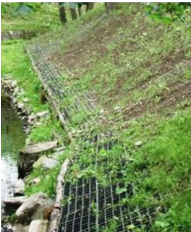
Oživené drôtené konštrukcie
